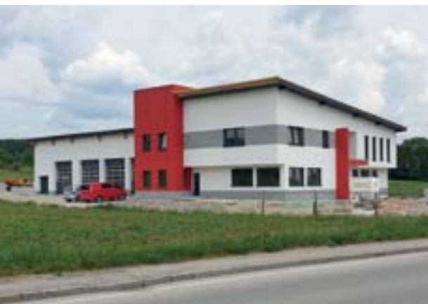
Das neue Feuerwehrhaus der FF Ternitz-Rohrbach wird auch Katastrophenschutzzentrum
