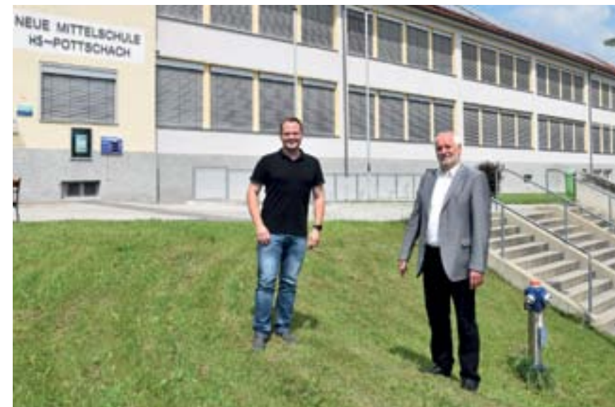
Foto: LAbg. Vizebürgermeister Mag. Christian Samwald und EVN-Projektleiter Ing. Johann Birnbauer vor dem neu angeschlossenen Objekt NMS/VS Pottschach
