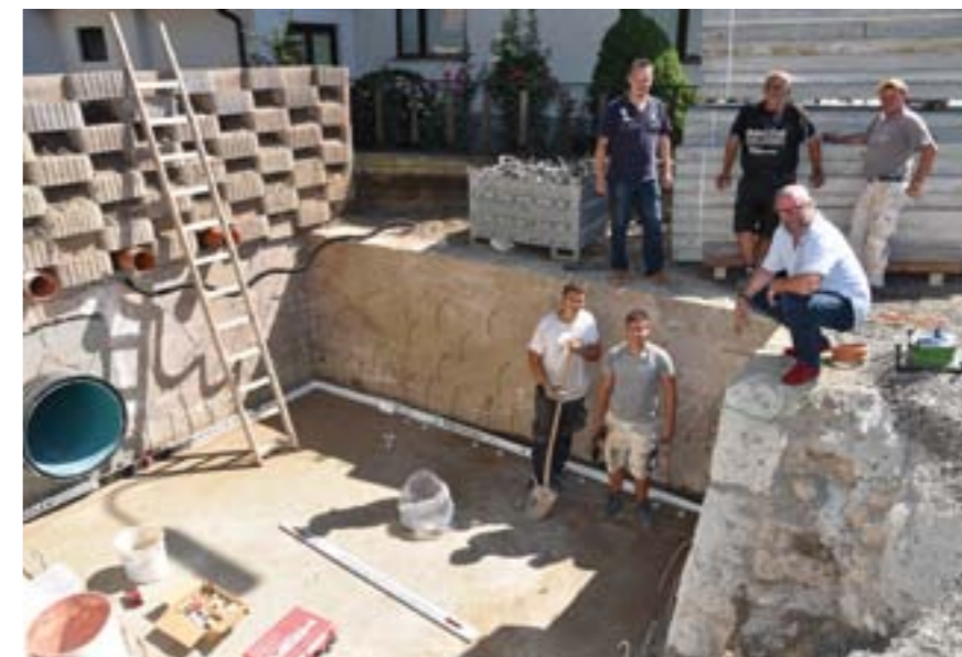
Foto: Stadtrat Gerhard Windbichler und Bauamtsleiter Ing. Michael Schechl inspizieren die Arbeiten am neuen Einlaufbauwerk in Raglitz
