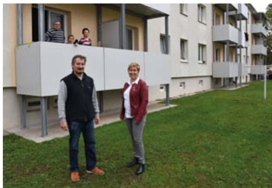
Die Bewohner der Wohnhausanlage Spiessgasse freuen sich über neue Balkone.
