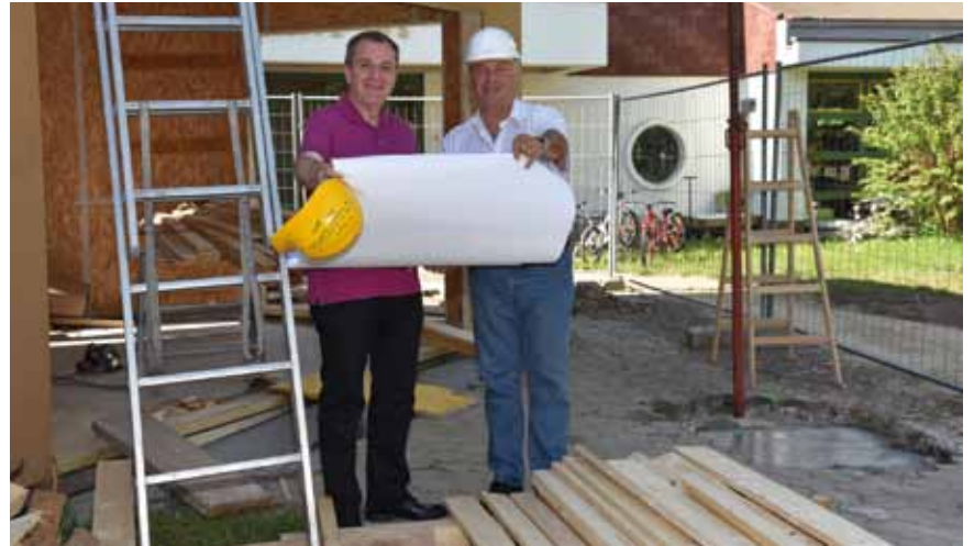
Foto: Bürgermeister Rupert Dworak und Stadtrat Franz Stix bei der Besichtigung der Baustelle
