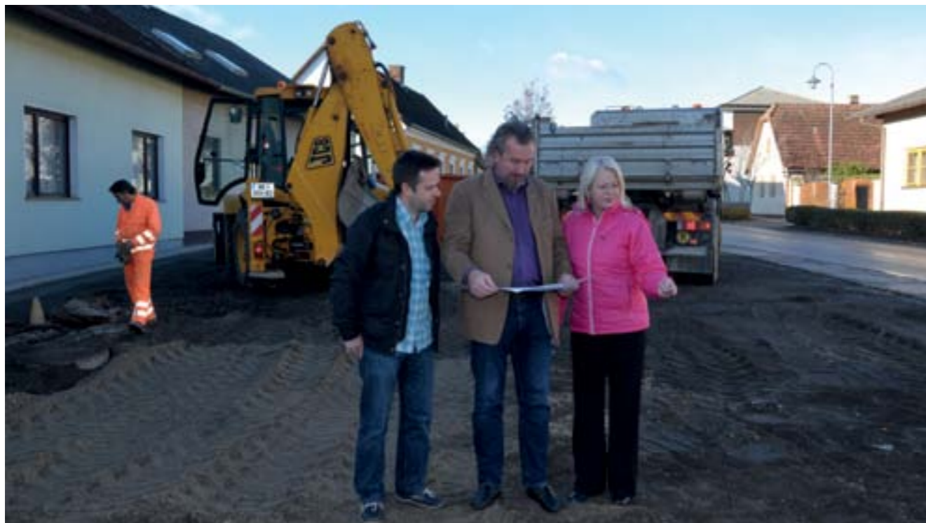
Foto (v.r.n.l.): Stadträtin Mag. Andrea Reisenbauer, Stadtrat Gerhard Windbichler und Gemeinderat Ing. Michael Riedl beim Baustart zum Rohrbacher Dorfplatz
